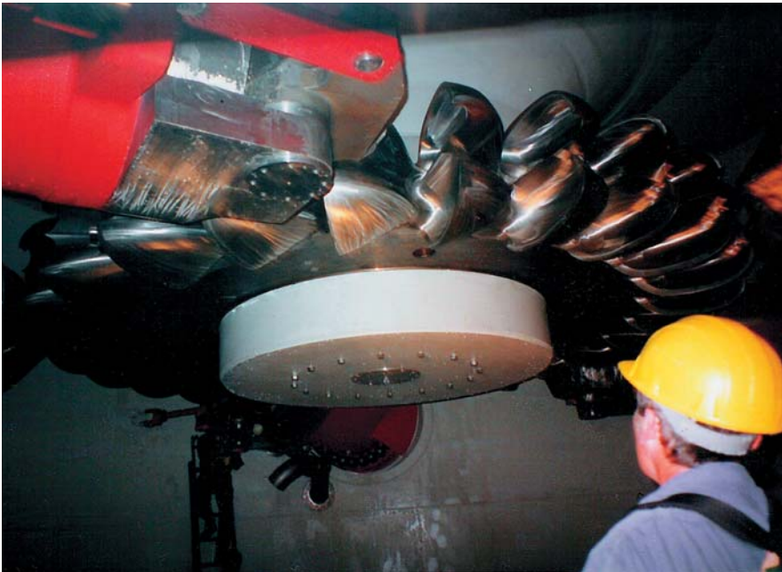
423 მგტ სიმძლავრის პელტონის ტურბინის ექსპლუატაციაში გაშვება, ბიედრონი, შვეიცარია
