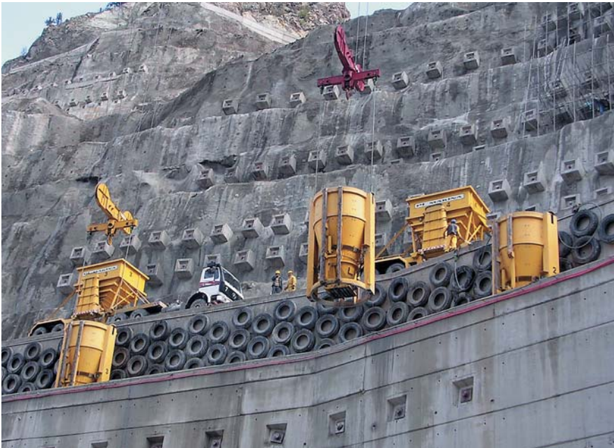
დერინერის ჰიდროელექტროსადგური, თურქეთი საანკერო ბურები თაღოვანი კაშხლის ზეით (სიმაღლე 253 მ)
