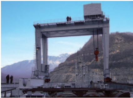
Système de grue de levage pour batardeau Stop log gantry lifting device crane
