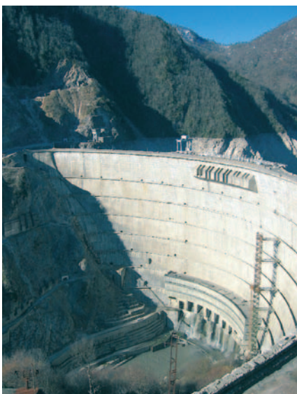
Partie aval du barrage Downstream face of the dam
