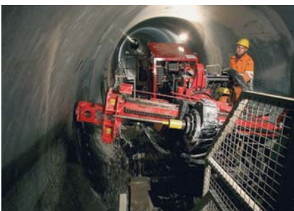
Travaux d'injection dans le puits Grouting works in the shaft
