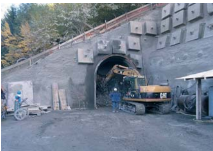
Portail de la galerie d'accès de Fontanettes supérieure Portal of the upper gallery of Fontanettes
