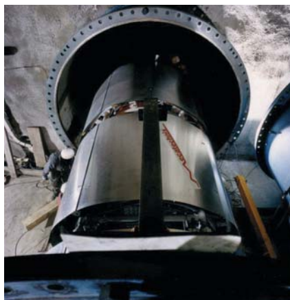
Introduction du gabarit télescopique dans le puits Introduction of the telescopic template in the shaft
