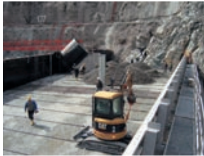
Début des travaux de bétonnage du barrage-voûte de Deriner (11 décembre 2005)
