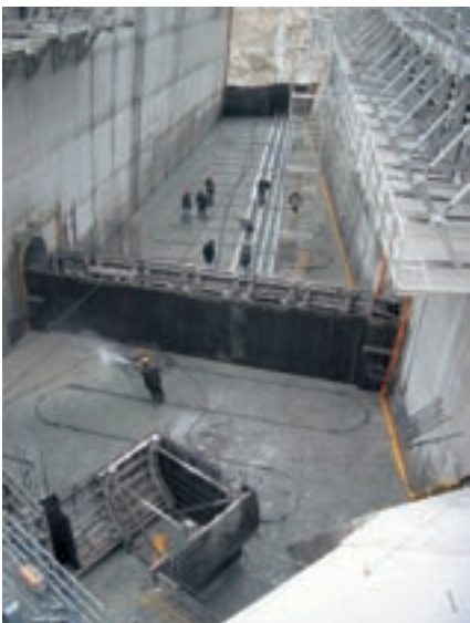
Préparations avant la levée de bétonnage – vue du système de conduites de refroidissement (février 2008)
