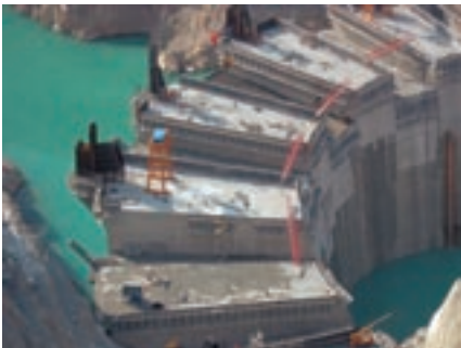
Bétonnage et installation des ouvrages d'entrée des vidanges de demi-fond (février 2008) Concreting and installation of the orifice spillways inlets (February 2008)
