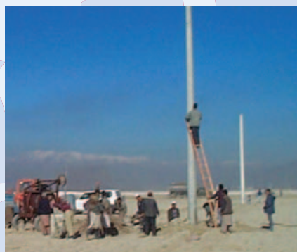
Travaux de bétonnage d'un pylône à Kaboul Concrete works of a tower in Kabul
