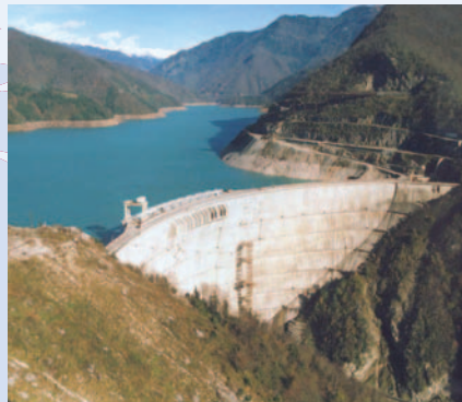
Réhabilitation du barrage d'Enguri, Georgia Rehabilitation of Enguri dam, Georgia
