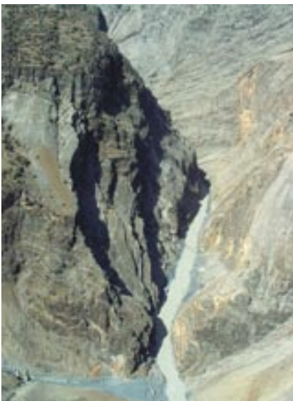
Vue aérienne amont du site du barrage Upstream aerial view of the dam site
