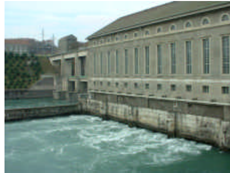
Usine de Chancy-Pougny
