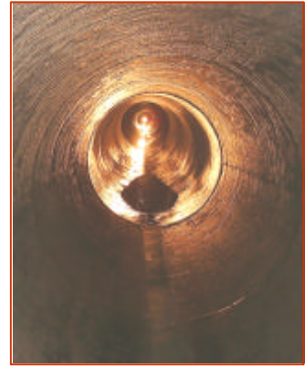
Reconstruction de conduite forcée
