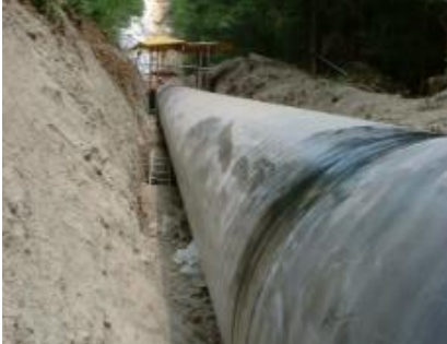
Remplacement de la conduite forcée de la Peuffeyre - Suisse
