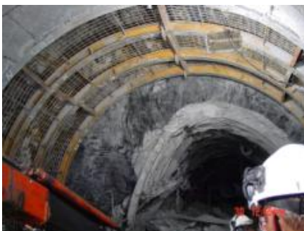
Réhabilitation du profil du tunnel Yacambu – Qubor - Vénézuéla
