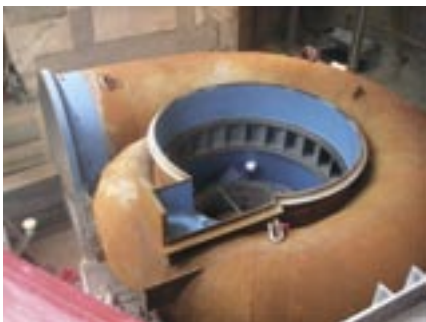
Réfection de la centrale de Hauterive (FR), Suisse
