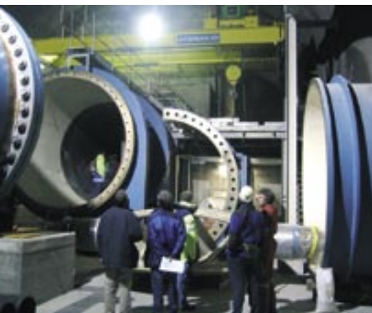
Aménagement hydroélectrique de Cleuson-Dixence, réhabilitation du puits blindé, Suisse
