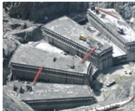
Barrage-voûte de Deriner, premières levées de bétonnage, Turquie
