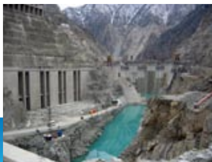
Vue aval de l'aménagement de Deriner - Turquie
