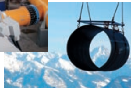
Transfert de virole du puits blindé de Cleuson-Dixence - Suisse
