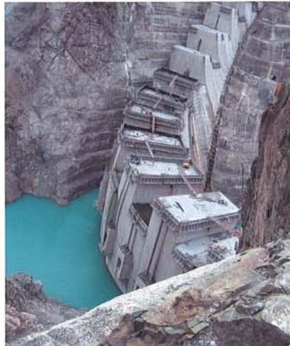
Barrage-voûte de Deriner, Turquie
