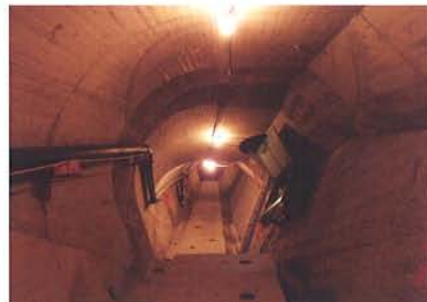
Confortement du barrage des Toules, Suisse Nouvelle galerie
