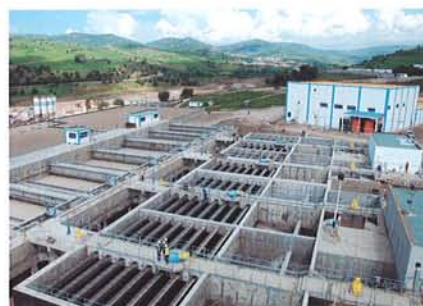
Transfert d'eau de Koudiat Acerdoune, Algérie Station de traitement
