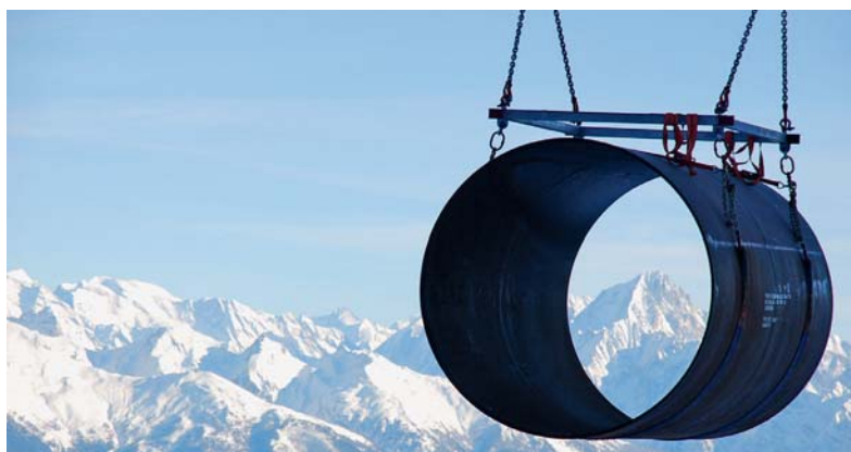
Remplacement de la conduite forcée, Aménagement de Cleuson-Dixence, Suisse
