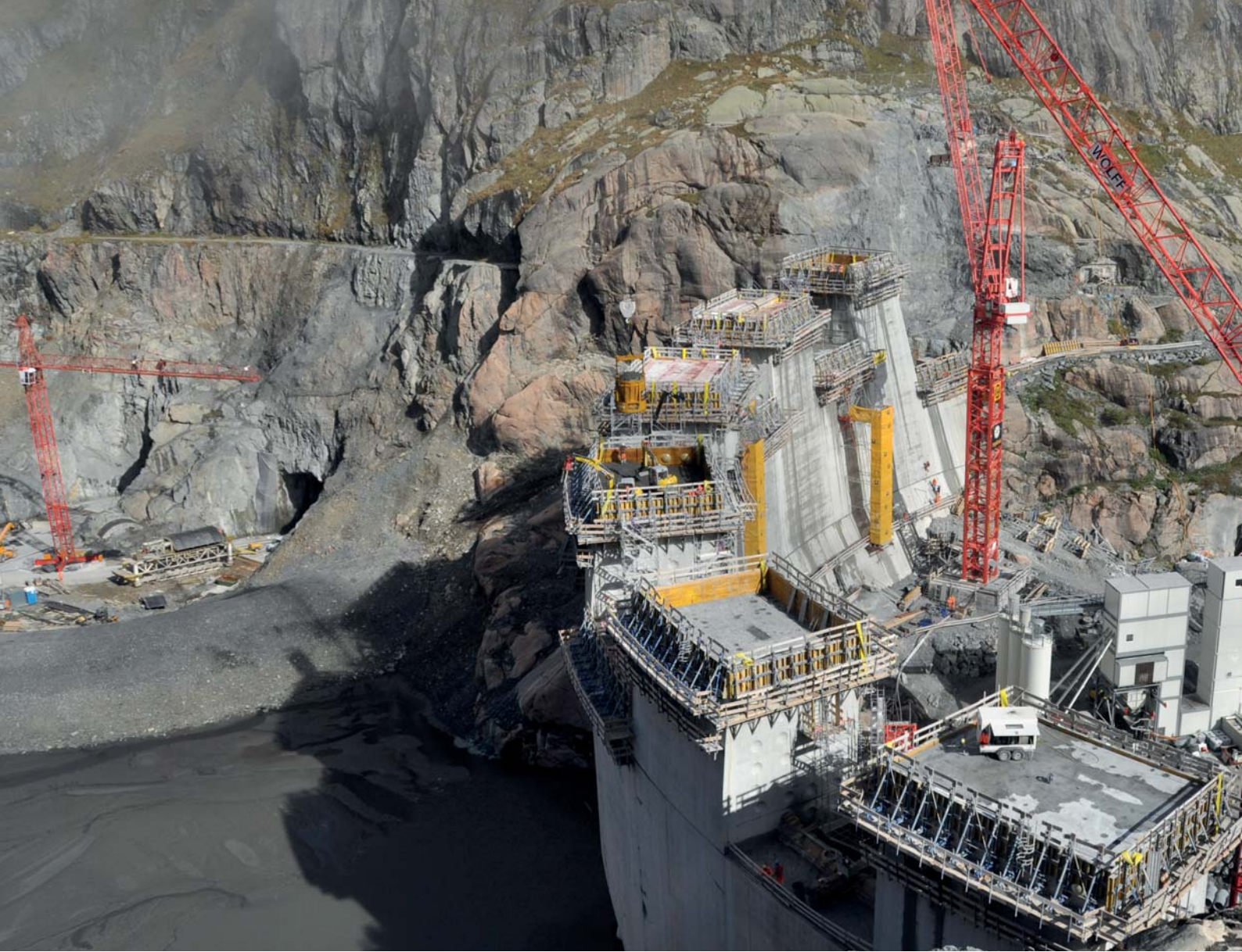
Surélévation du barrage-voûte du Vieux Emosson, Suisse
