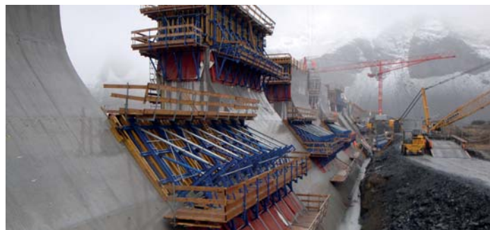
Barrage-poids de Muttssee, Suisse
