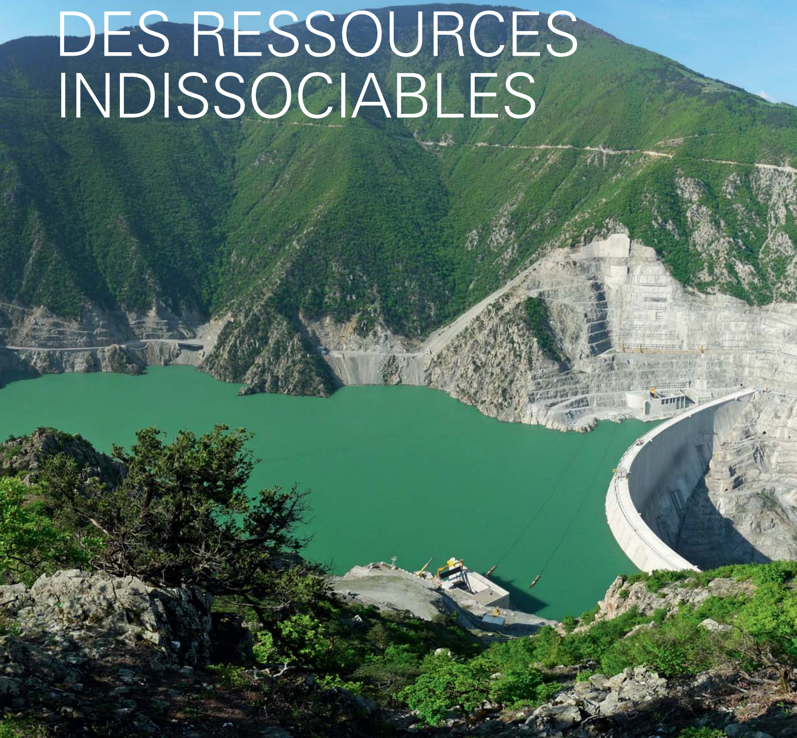
Barrage et usine hydroélectrique de Deriner, Turquie
