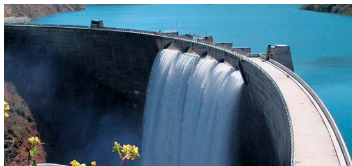
Barrage-voûte de Shahid Rajaei, Iran
