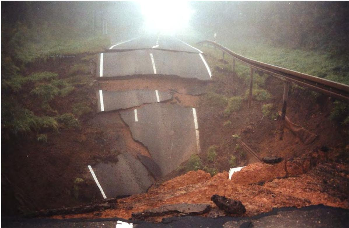
Abb. 9: Nachbruch des Erdfalles auf der B 180 im Oktober 2001 mit vollständiger Zerstörung der Fahrbahn (Foto: DAUTERSTEDT)
