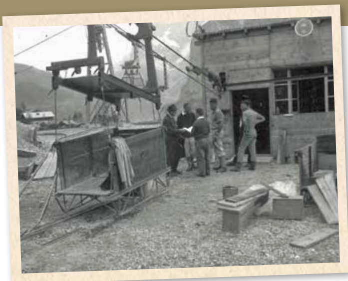
Effrayant: des caisses de ce type ont également servi à transporter des personnes jusqu'au sommet avec le téléphérique de chantier
