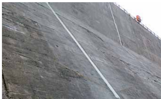
Rainures de décharge côté aval du barrage de Salanfe en Valais pour soulager les contraintes de compression
