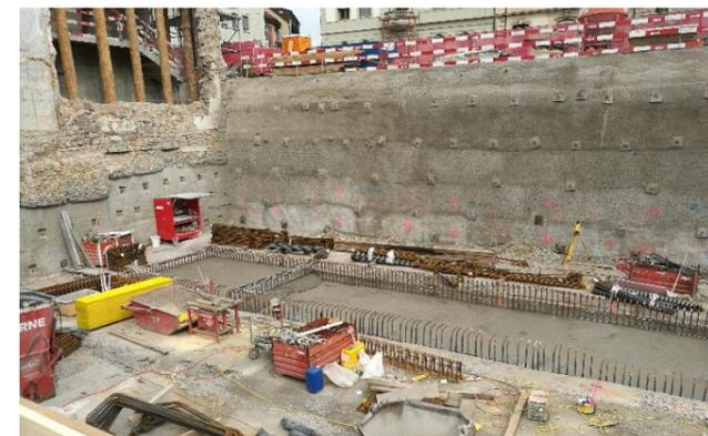
Fundamente, Unterfangungen, Nagelwand, Spriessungen im Bestand
