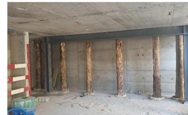
Einbau einer Stahlkonstruktion als Wandabfangung im Bestand
