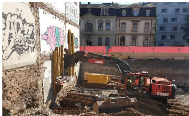
Entfernung des Rückbaumaterials im Eckgebäude durch die Brandwand
