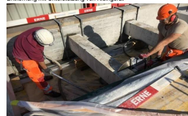
Schneiden mit Kleingerät
