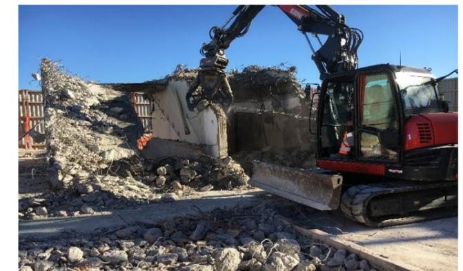
Betonbeissen mit Kleinbagger
