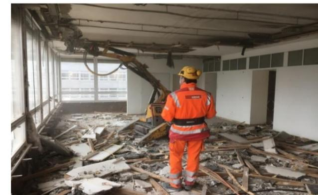
Entkernung mit Unterstützung von Kleingerät
