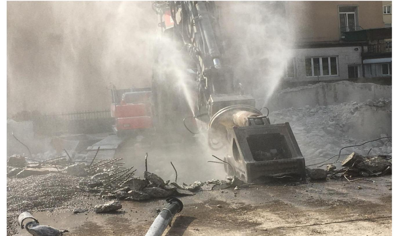
Betonbeissen mit gleichzeitigem Staubniederschlag
