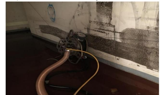
Sanierung PCB-haltige Wandfarbe mit Schleifroboter
