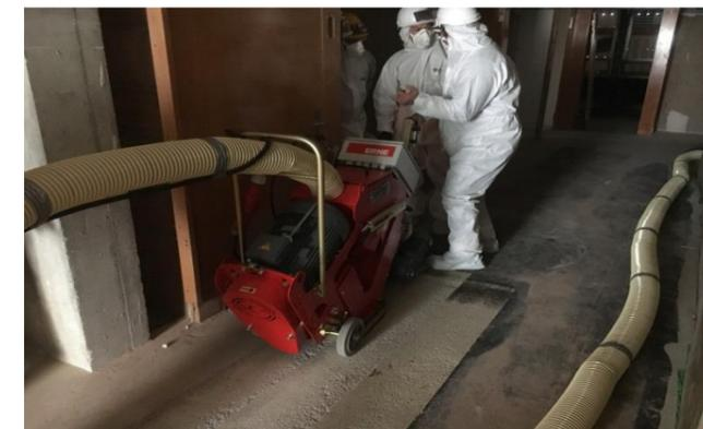
Sanierung Asbest-haltiger Plattenkleber: Schleifen mit Direktabsaugung
