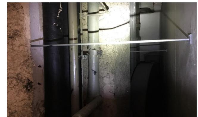
Mit Spritzasbest ummantelte Metall-Lüftungskanäle
