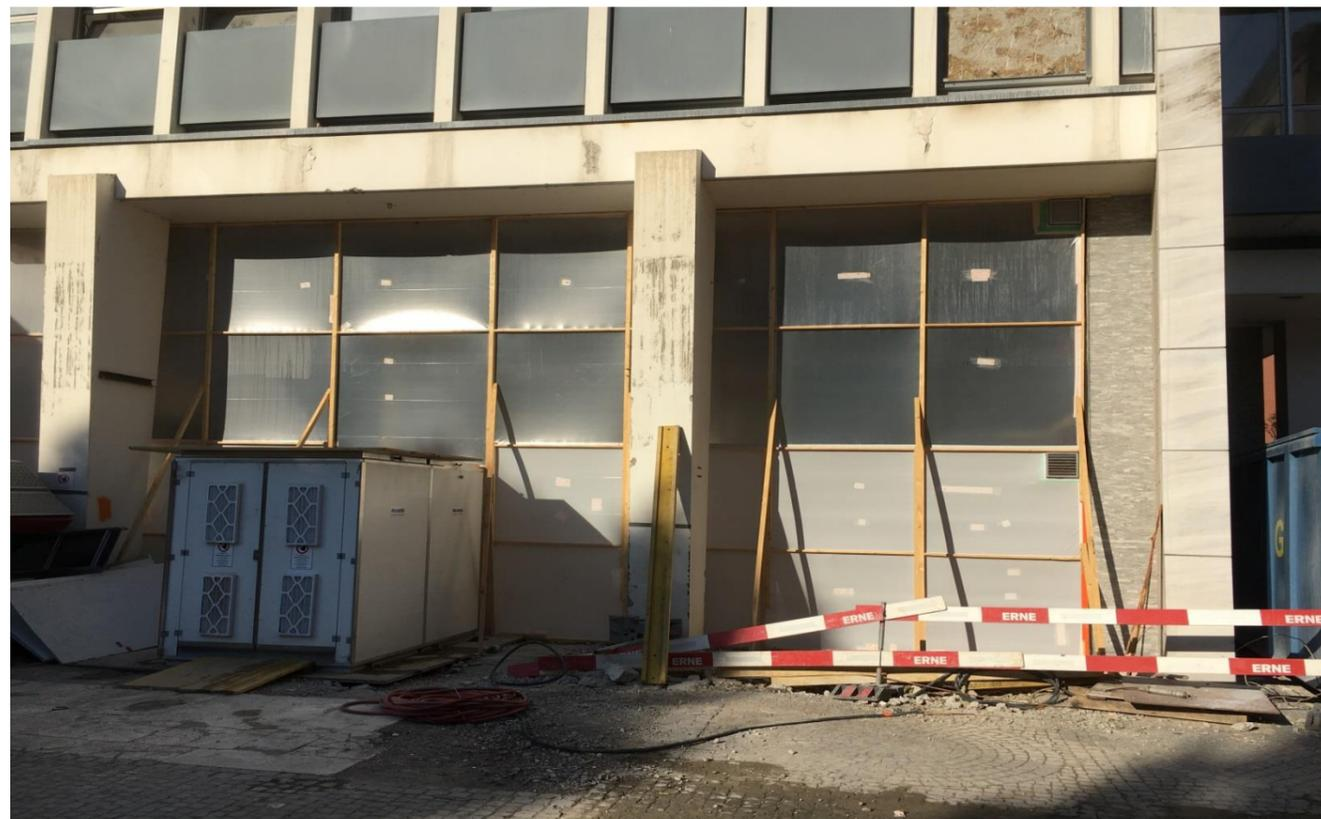
Asbestsanierung: Schwarzbereich mit Personen- und Materialschleuse
