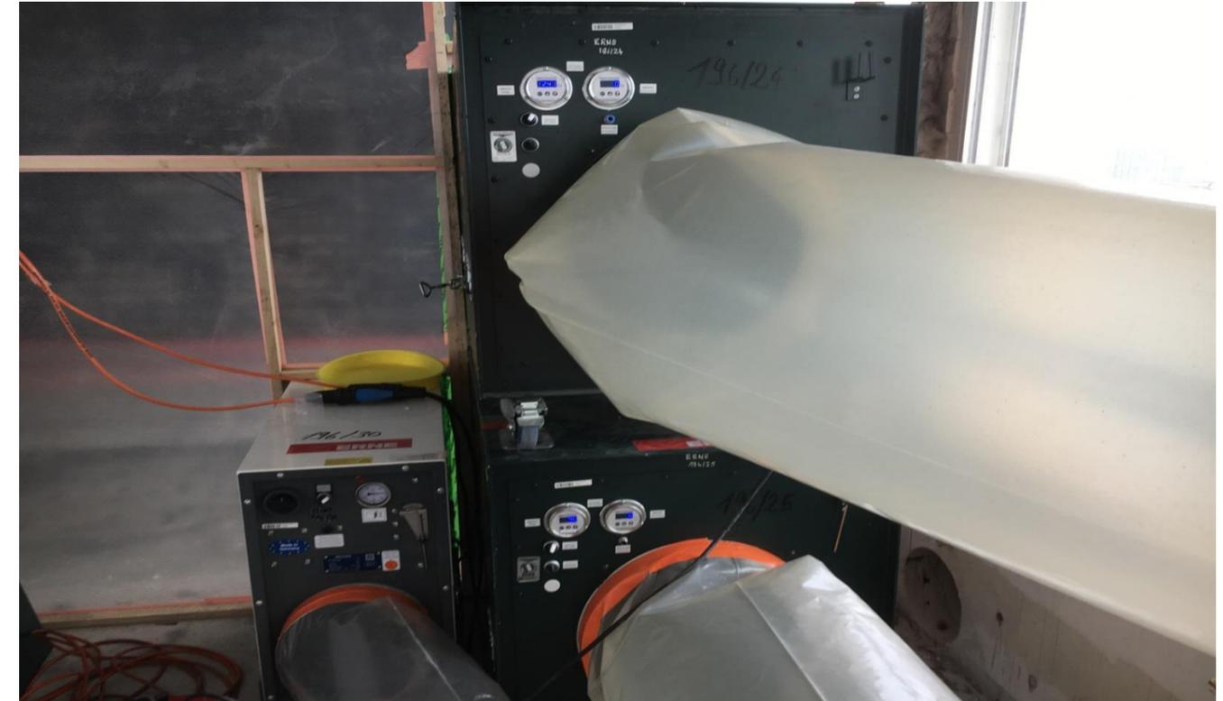
Asbestsanierung: Schwarzbereich mit Unterdruckhaltergeräte
