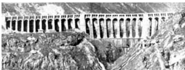
Vue générale du barrage du Gléno, face aval
