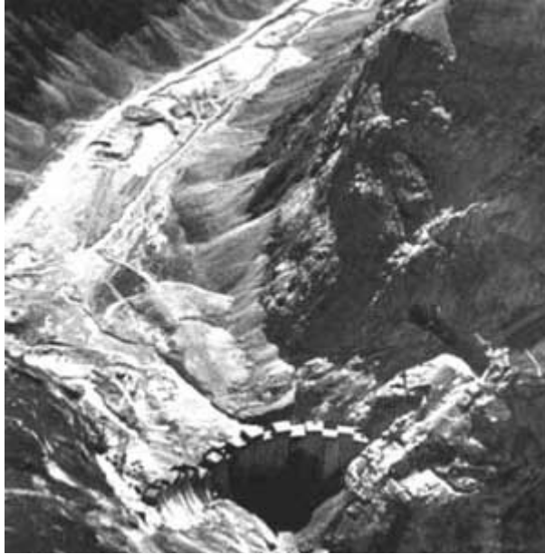
Barrage de Limmern en construction, 1961 (Photo Schönwetter, Glarus)
