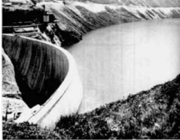
Barrage de Nalps (Photo H. Rostetter, Ilanz)
